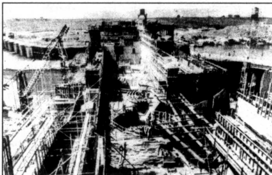
Represa de Baygorria. (En construcción. Fotografía tomada en febrero de 1959)
